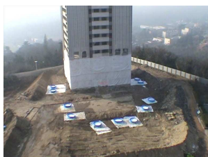
Déconstruction à Rilleux la Pape (69) par foudroyage avec pulvérisation pyrotechnique de rideaux d'eaux anti poussières.
