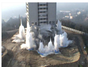
Déconstruction à Rilleux la Pape (69) par foudroyage avec pulvérisation pyrotechnique de rideaux d'eaux anti poussières.
