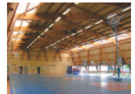
Structure en bois lamellé-collé
