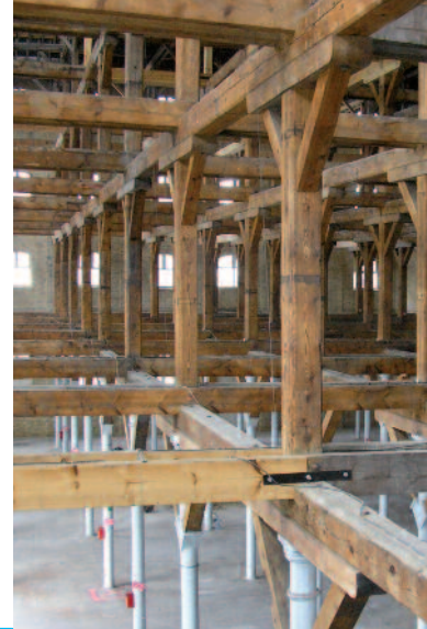
Structure bois d'un ancien entrepôt à tabac à Dunkerque
