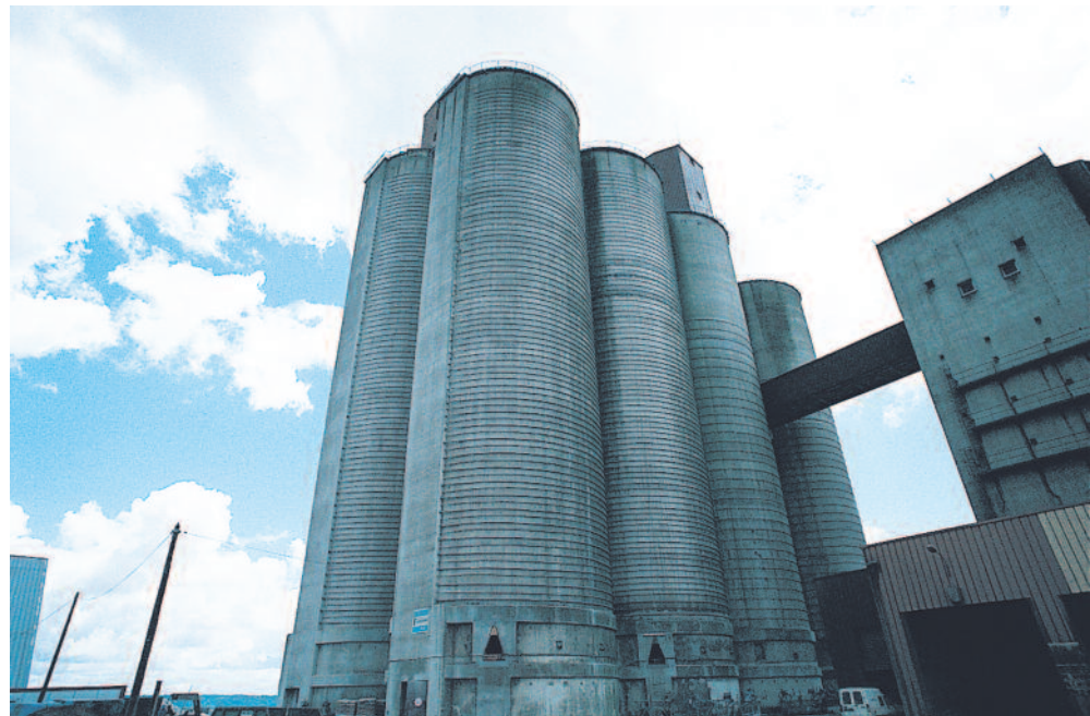
Silo à grains
