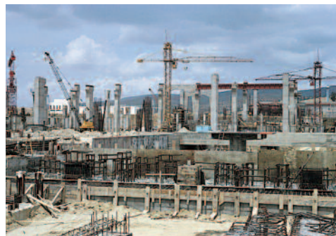
Interventions sur chantier
