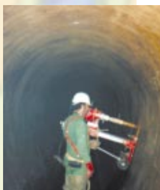
Carottage béton en égout
