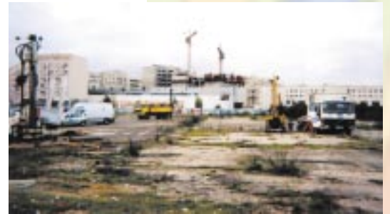
Sondage pour diagnostic de pollution des sols et eaux
