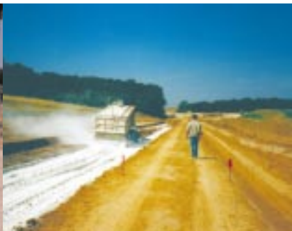
Contrôle de Traitement de Sol
