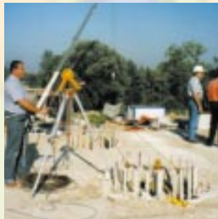
Contrôle de Fondations par Carottage Sonique
