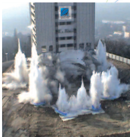
Réduction des poussières par rideaux d'eau pyrotechnique
