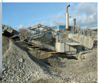
Valorisation des déchets inertes par concassage
