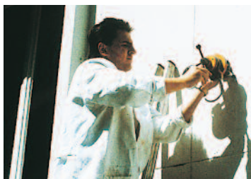
Essai d'adhérence in situ par traction directe.
