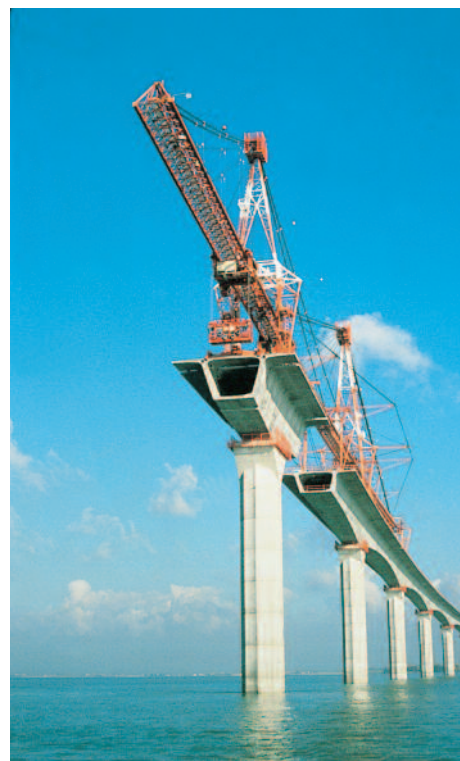
Pont de l'Île de Ré.
