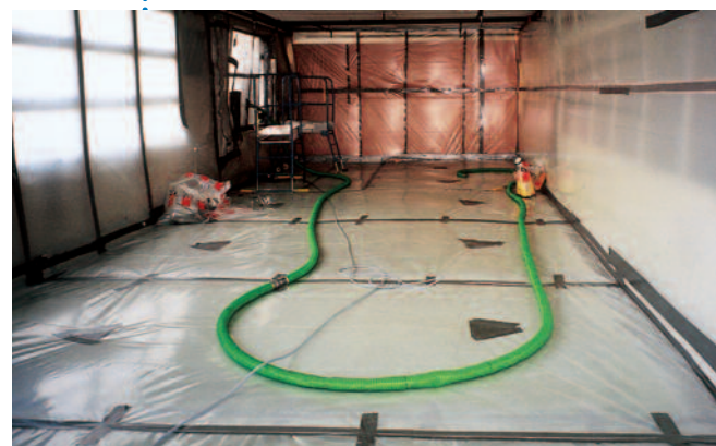
Vue générale de la zone à réhabiliter, et de son confinement
