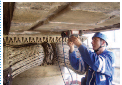
Recherche d'armatures métalliques par méthode radar
