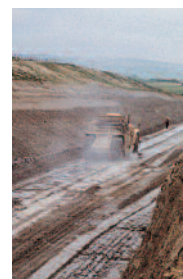
Traitement de sol : contrôle de terrassement.
