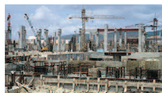
Interventions sur chantier.
