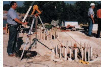
Carottage sonique sur pieu
