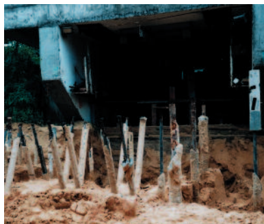
Station d'essais de CEBTP SOLEN Micropieux du projet FOREVER
