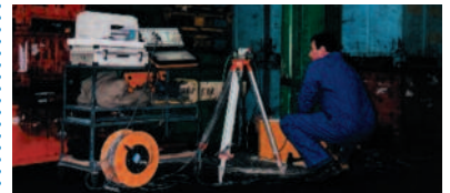
Recherche d'ancrage de fondation d'un poteau d'une usine.
