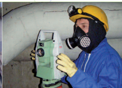
Relevé de conduite dans galerie polluée
